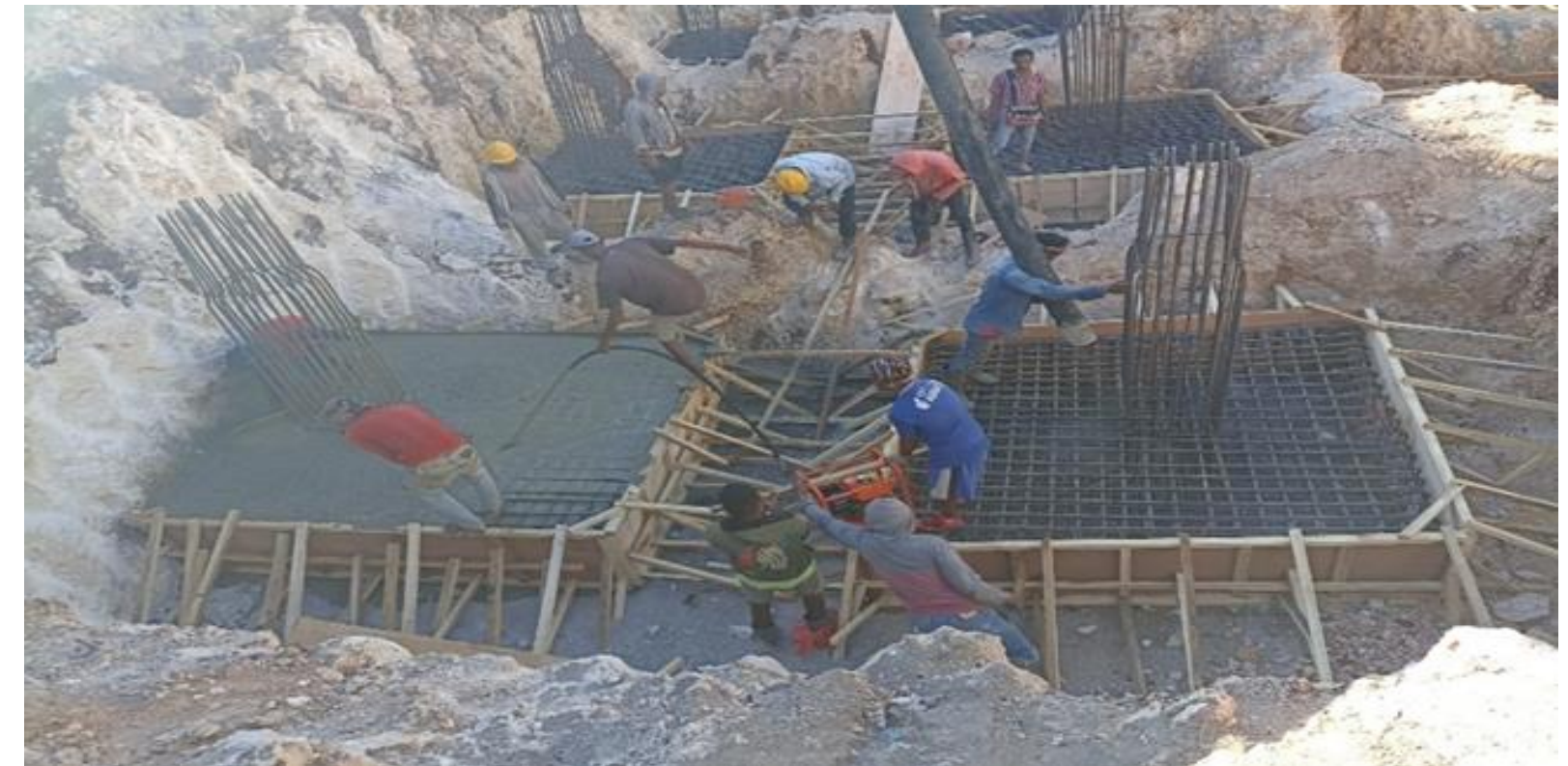
Gambar 3.8 Pengecoran Pondasi foot plate
