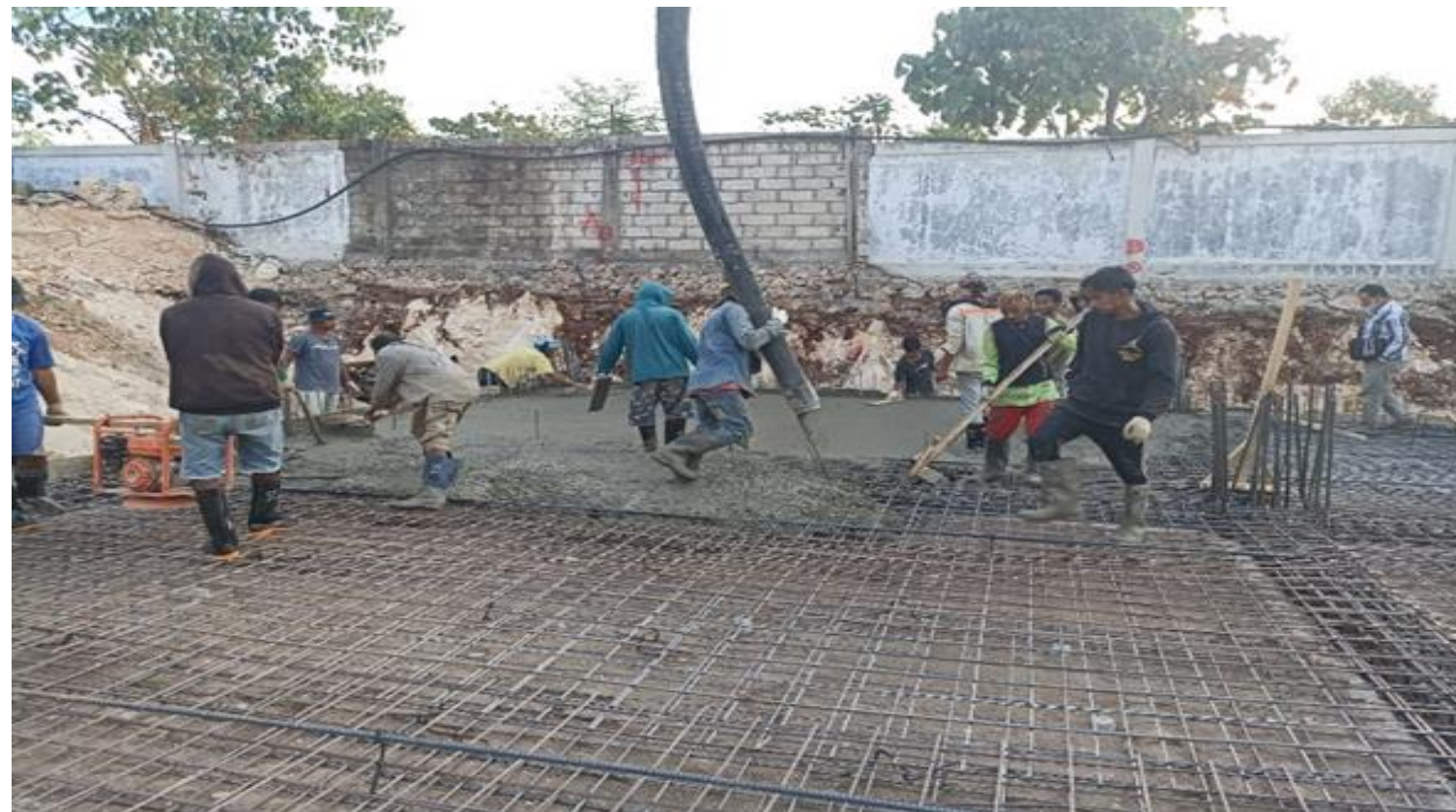
Gambar 3.10 Pekerjaan Pengecoran Sloof Dan Lantai Basemant.
