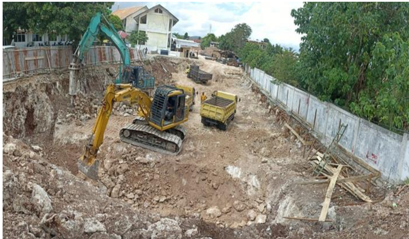
Gambar 3.4 Proses Galian Basemant (Sumber : Dokumentasi Kerja Praktek, 2023.)
