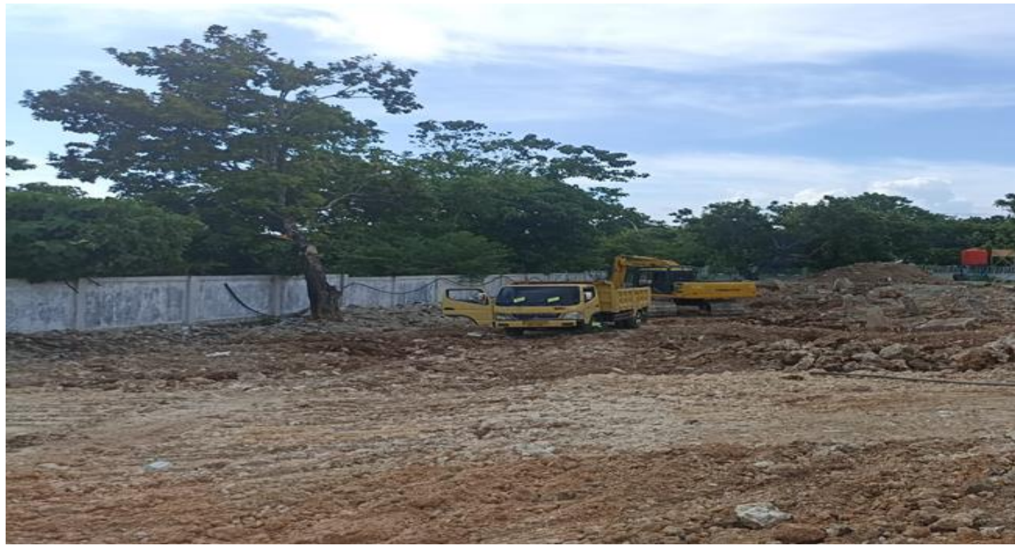
Gambar 3.1 Pembersihan Lahan Proyek (Sumber : Dokumentasi Kerja Praktek, 2023.)
