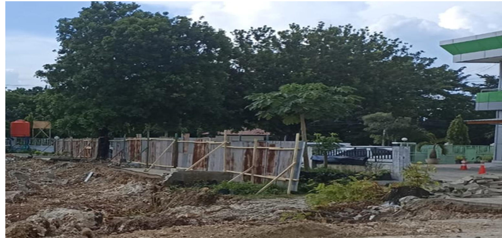
Gambar 3.2. Pembuatan Pagar Sementara (Sumber : Dokumentasi Kerja Praktek, 2023.)
