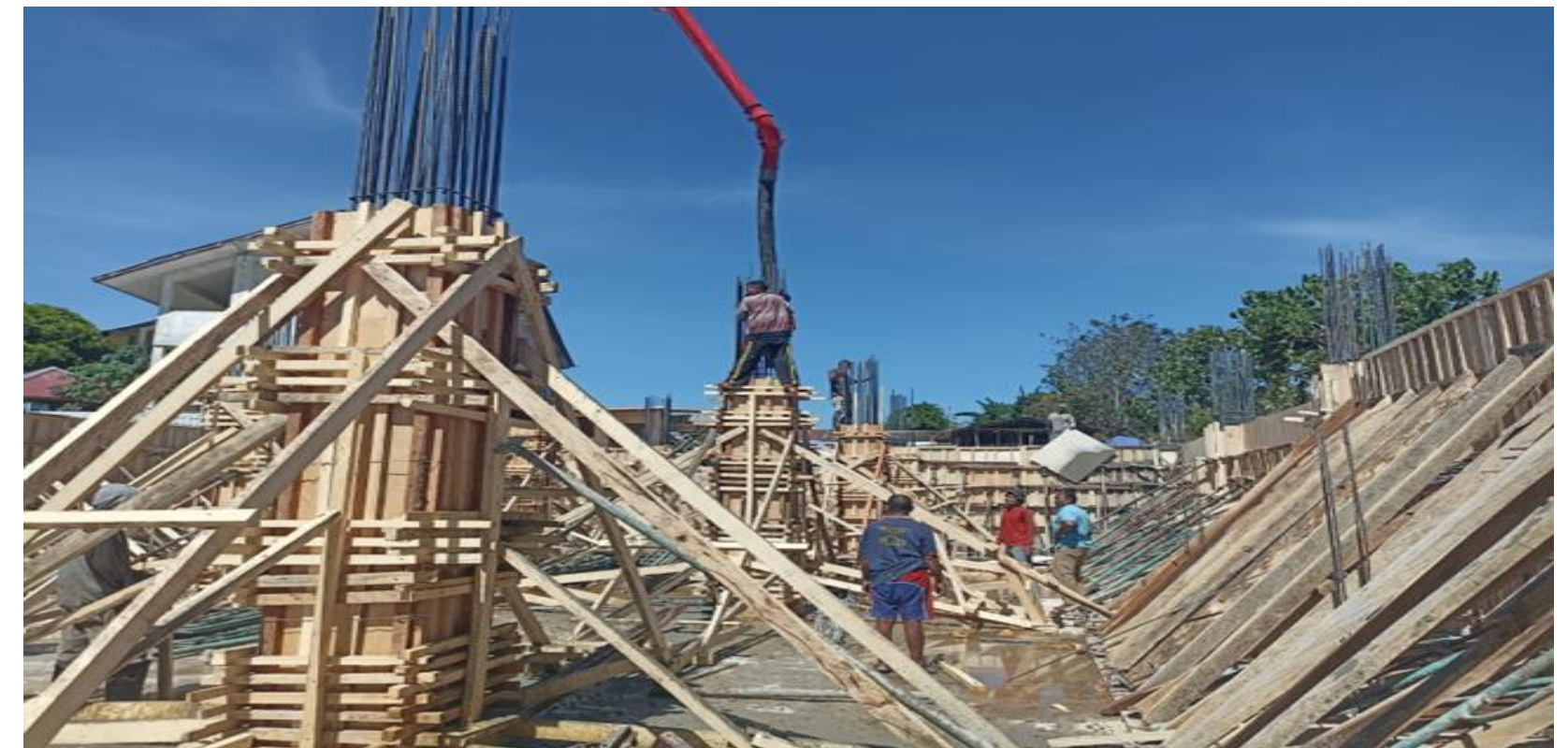
Gambar 3.12 Pengecoran Kolom Basemant
