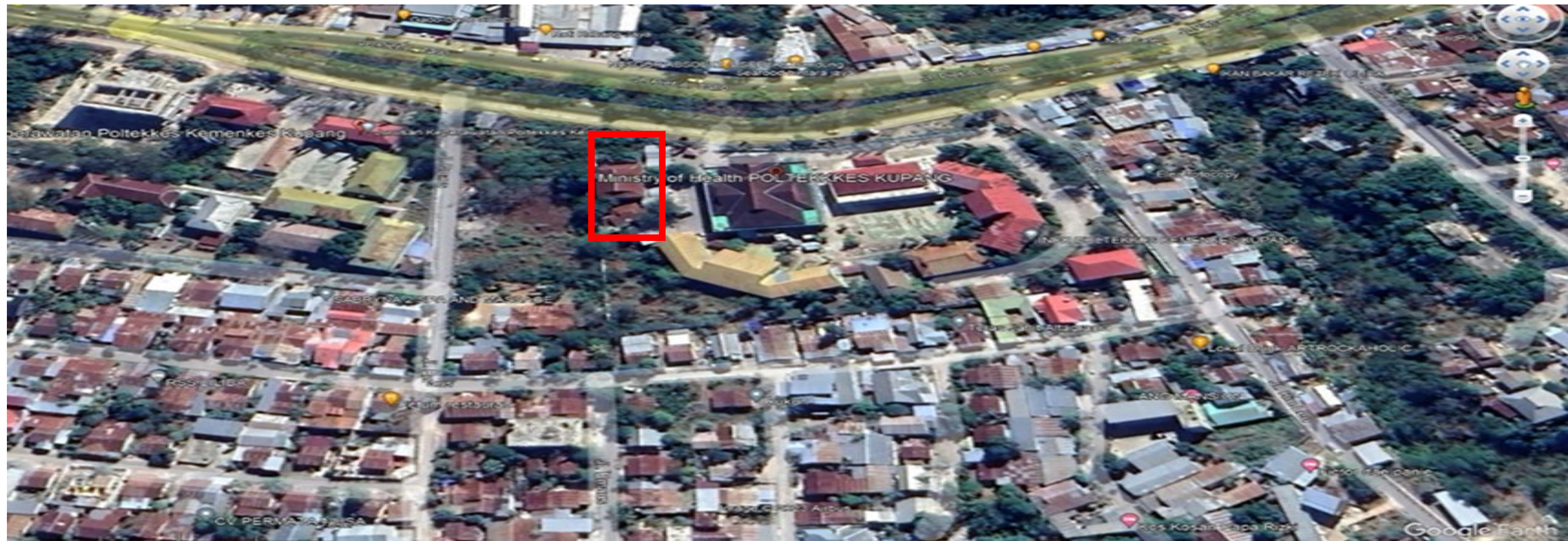
Gambar 1.2 Lokasi Proyek Pekerjaan pembangunan gedung Layanan IT dan Perpustakaan Politeknik Kesehatan Kupang
