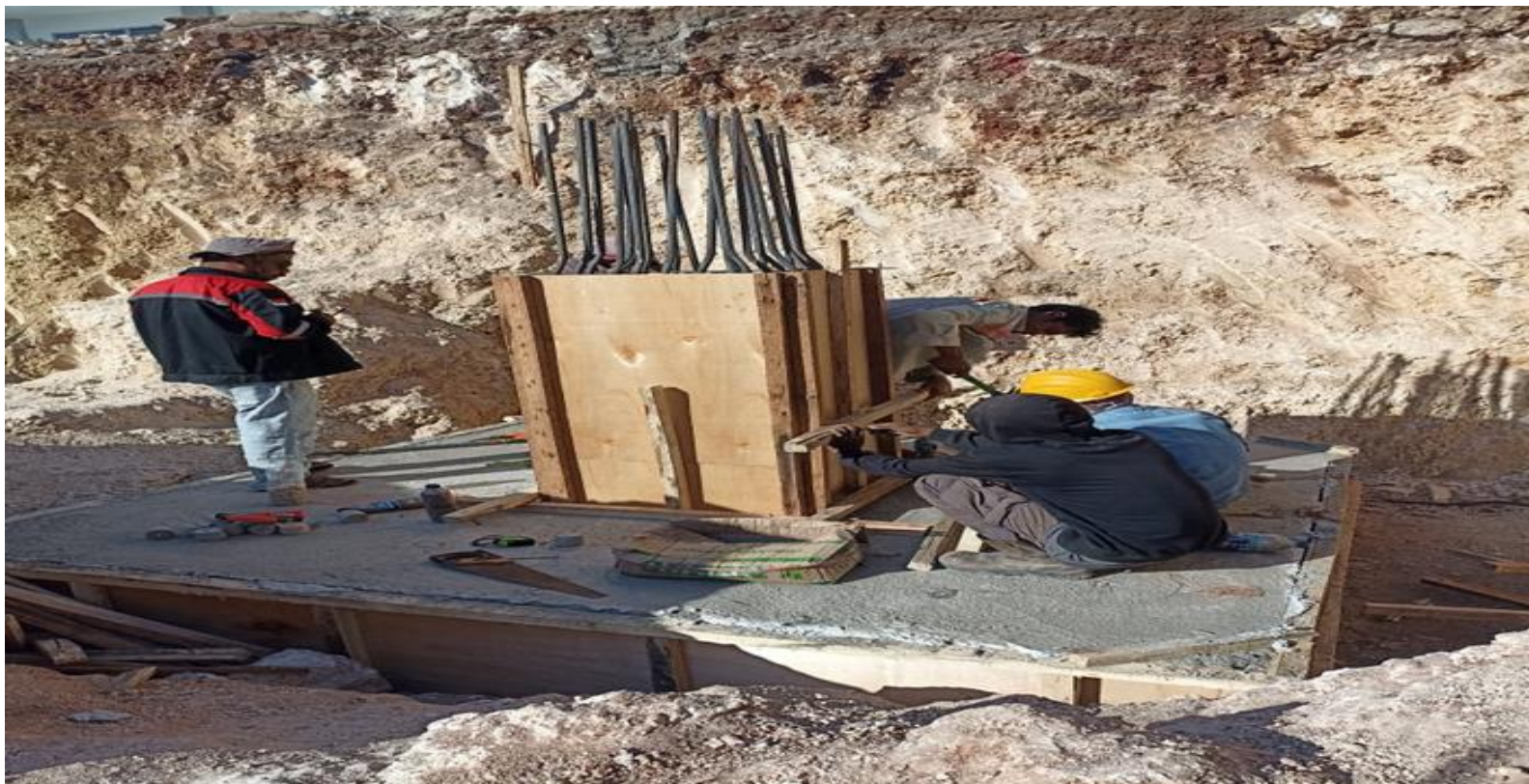
Gambar 3.7 pekerjaan Bekisting Kolom Pedestal
