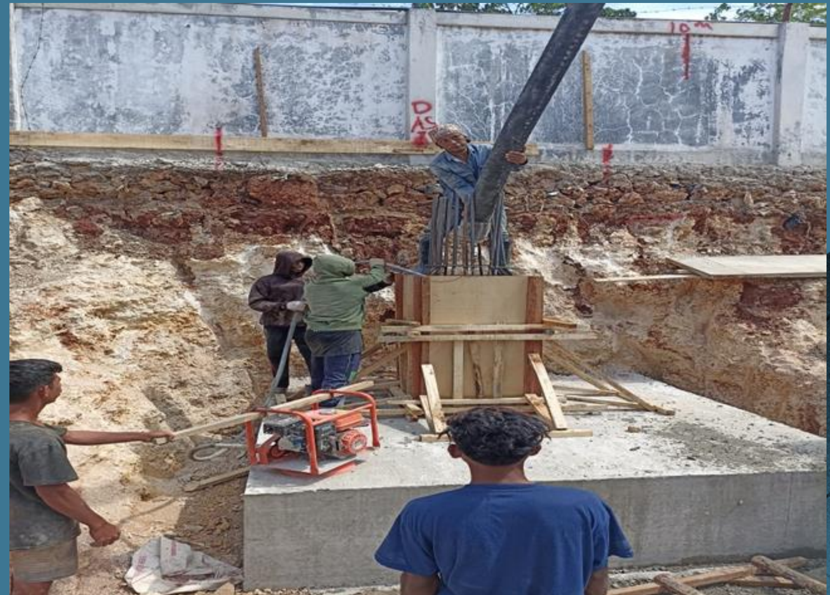
Gambar 4.2 Pengecoran Kolom Pedestal (Sumber : Dokumentasi Kerja Praktek, 2023)
