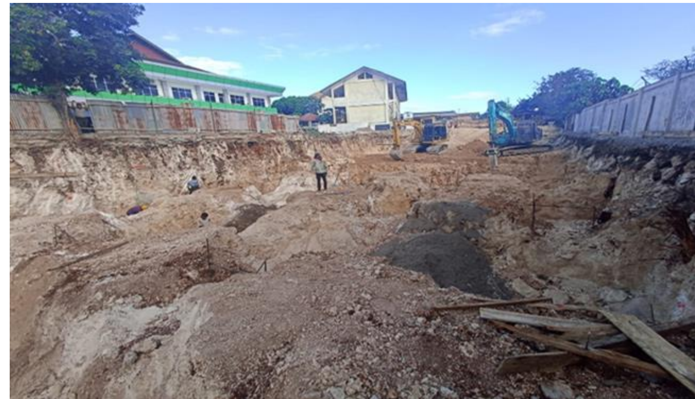
Gambar 3.5 Proses Penggalian Pondasi Pile Cup (Sumber : Dokumentasi Kerja Praktek, 2023)
