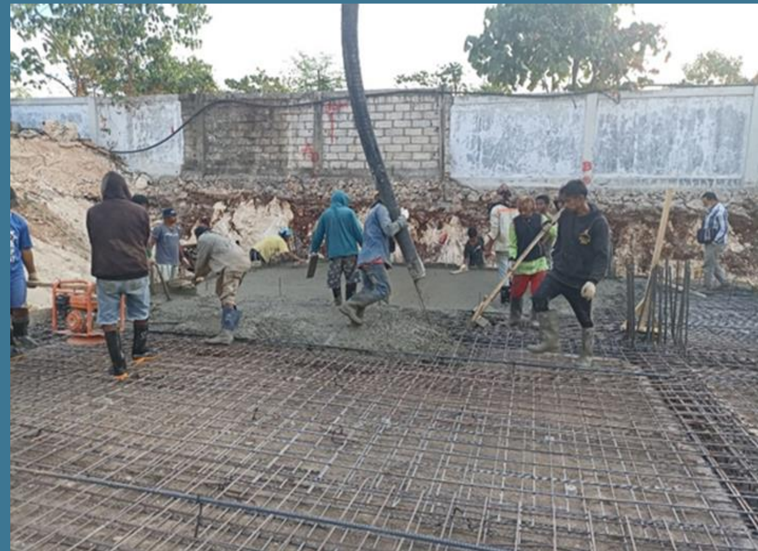
Gambar 4.4 Pengecoran sloof
