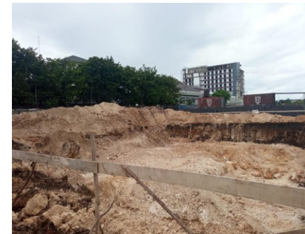
PEKERJAAN PEMASANGAN PATOK (BOWPLANK)
