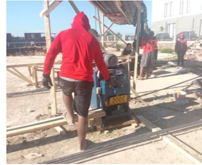
PEMOTONGAN BESI
