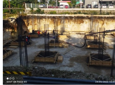
PENGECORAN PONDASI FOOTPLAT
