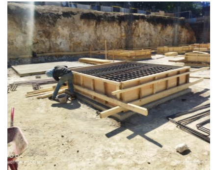
PEMASANGAN BEKISTING PONDASI FOOTPLAT
