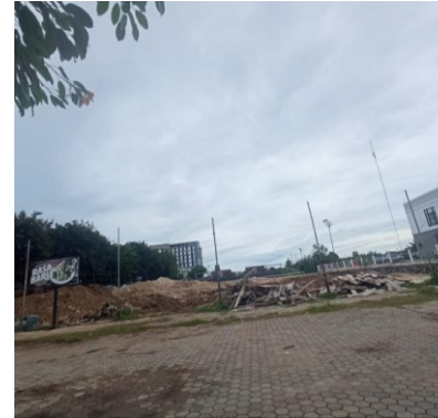
PEMBERSIHAN LAHAN PROYEK
