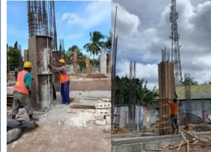
PEMBONGKARAN BEKISTING KOLOM PEDESTAL
