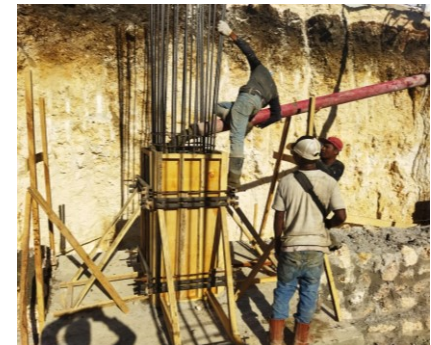
PENGECORAN KOLOM PEDESTAL
