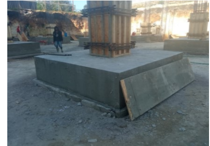
PEMBONGKARAN BEKISTING PONDASI FOOTPLAT
