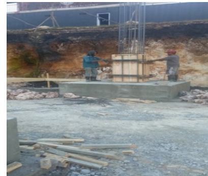
PEMASANGAN BEKISTING KOLOM PEDESTAL
