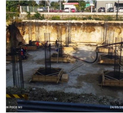
PEKERJAAN PONDASI FOOTPLAT
