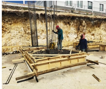
PEMBESIAN KOLOM PEDESTAL
